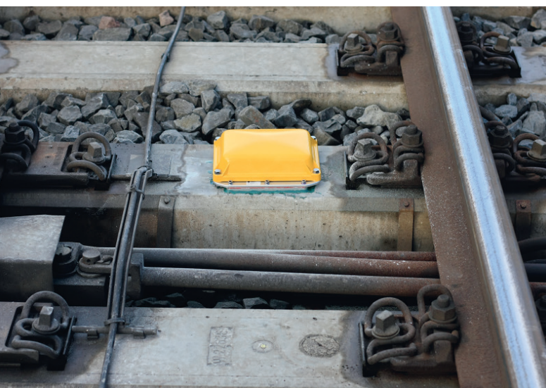
BILD 4: KONUX WSHL-Sensor auf einer Betonschwelle
